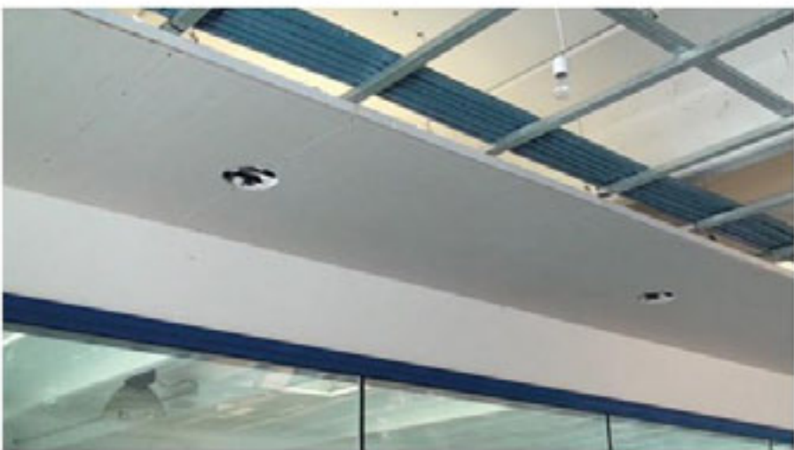
FASE 3: Finitura e rasatura pannelli
