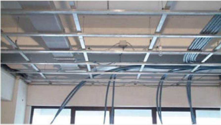
FASE 1 Realizzazione struttura metallica
